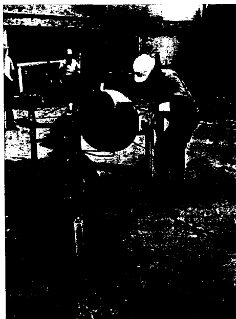
Foto 3 – Fabricação do concreto na betoneira estacionária de eixo inclinado
