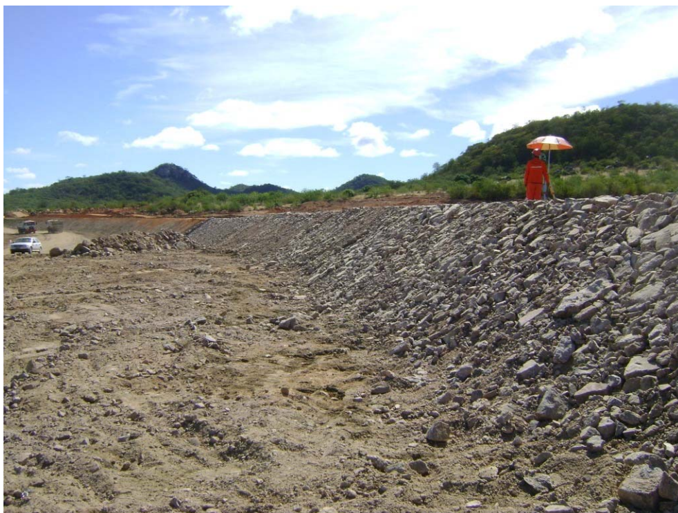
Foto 10 – Outra vista geral do enrocamento de proteção do canal CN-14, nas imediações da estaca 4352.
