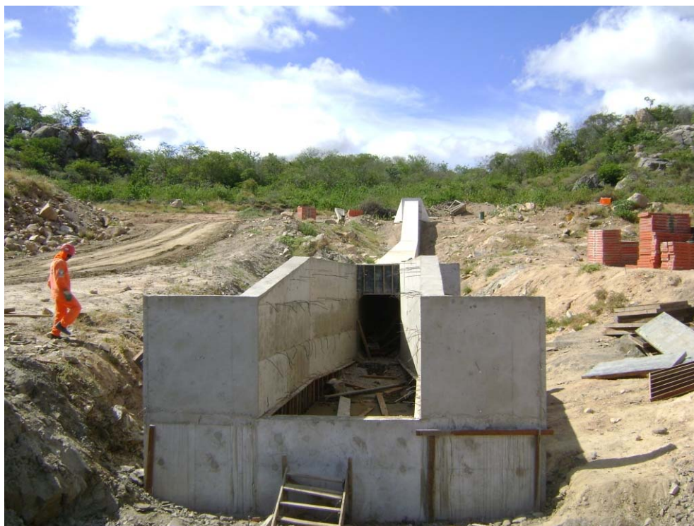
Foto 8 – Vista geral da saída do bueiro B004 do canal CN-14.
