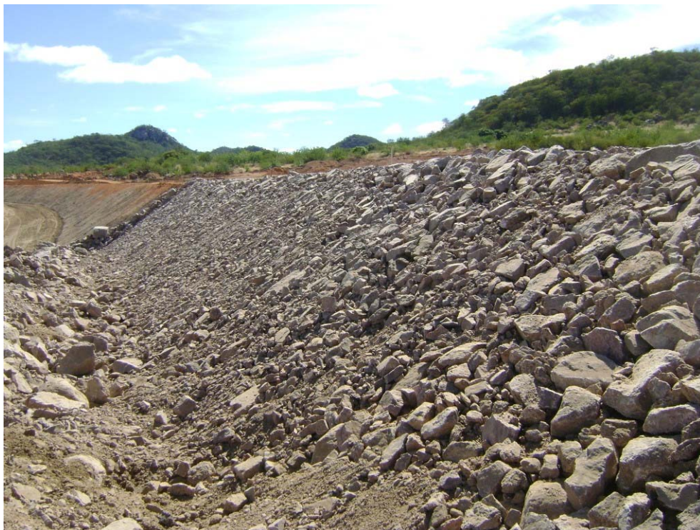
Foto 9 – Aspecto geral do enrocamento de proteção do canal CN-14, nas imediações da estaca 4352.
