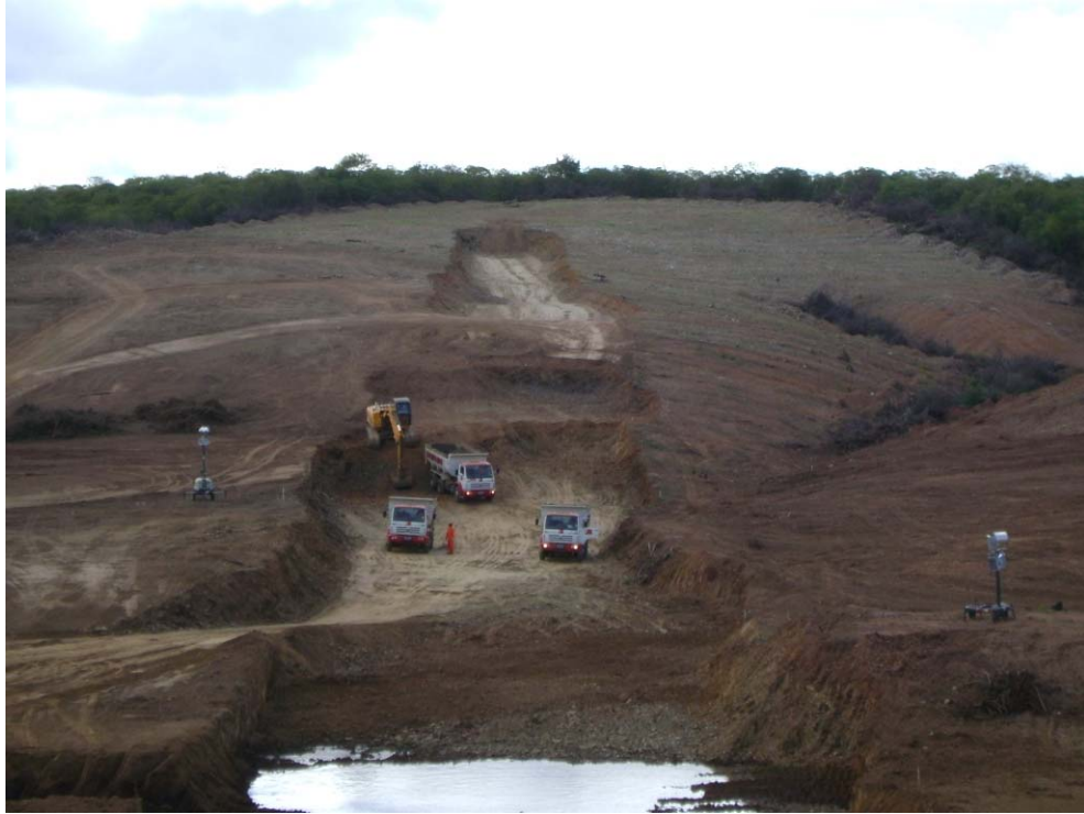
Foto 5 – Outra vista geral da escavação das fundações da Barragem de Milagres, nas imediações da estaca 18, observando-se o trecho central mais aprofundado.
