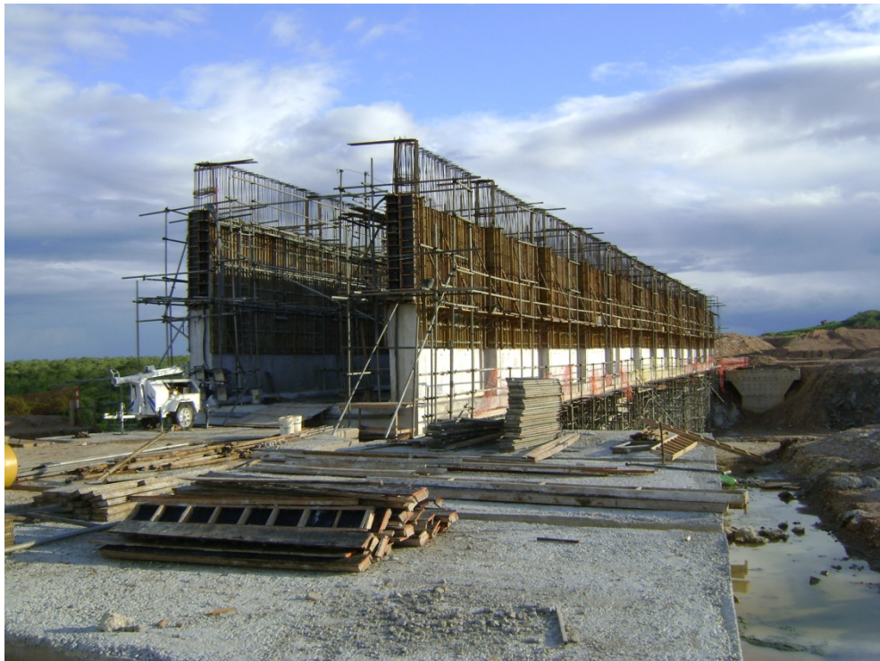
Foto 1 – Vista geral do Aqueduto Logradouro, com a concretagem das paredes em andamento.
