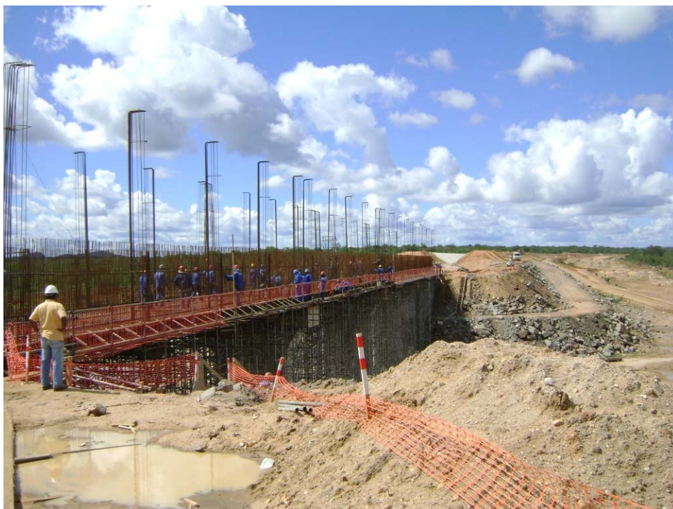
Foto 3 – Vista geral do Aqueduto Saco da Serra, com o início de montagem das armaduras das paredes, para posterior concretagem.
