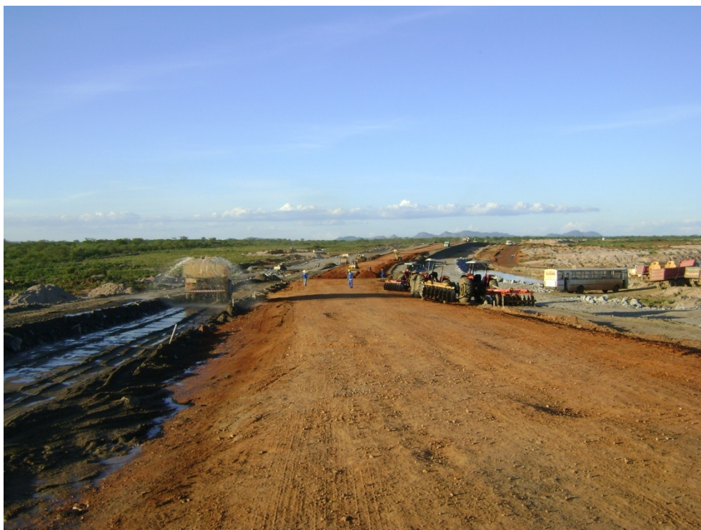
Foto 4 – Aspecto geral do alteamento do maciço compactado da Barragem de Serra do Livramento, próximo à estaca 45.
