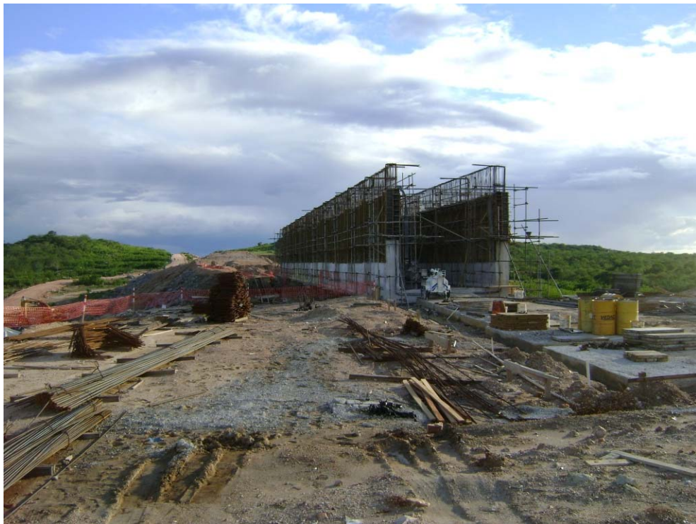
Foto 2 – Vista geral, por outro ângulo, do Aqueduto Logradouro, com a concretagem das paredes em andamento.
