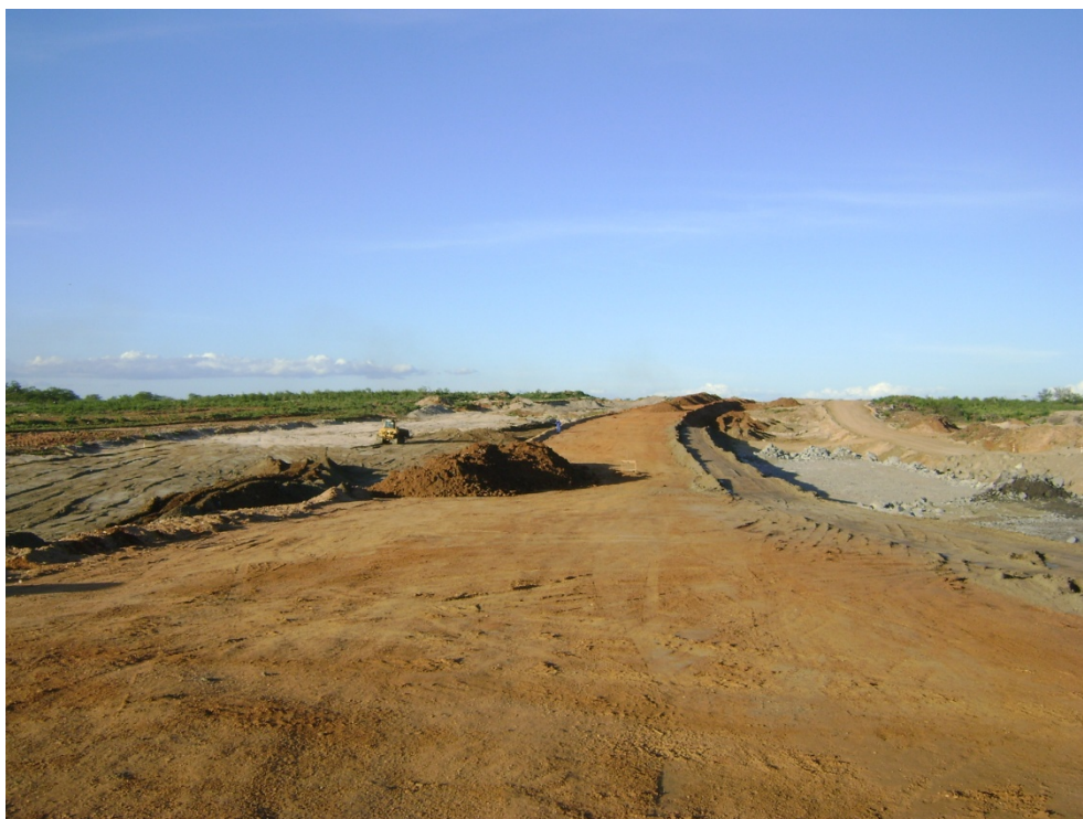
Foto 5 – Outra vista geral do alteamento do maciço compactado da Barragem de Serra do Livramento, próximo à estaca 82.
