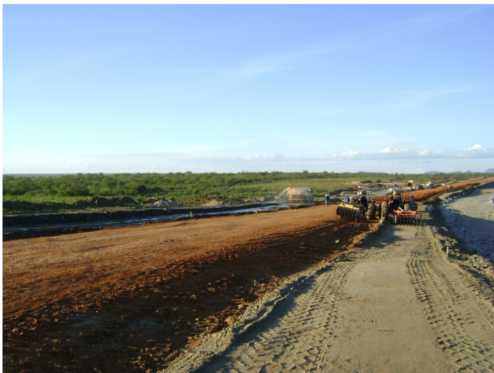
Foto 6 – Nova vista geral do alteamento do maciço compactado da Barragem de Serra do Livramento, próximo à estaca 39.
