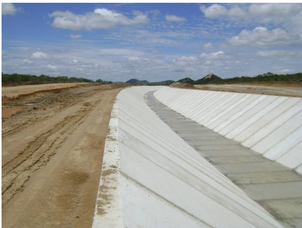
Foto 3 – Vista geral das obras do canal CN-05, num trecho com a concretagem das paredes e do fundo já executadas.
