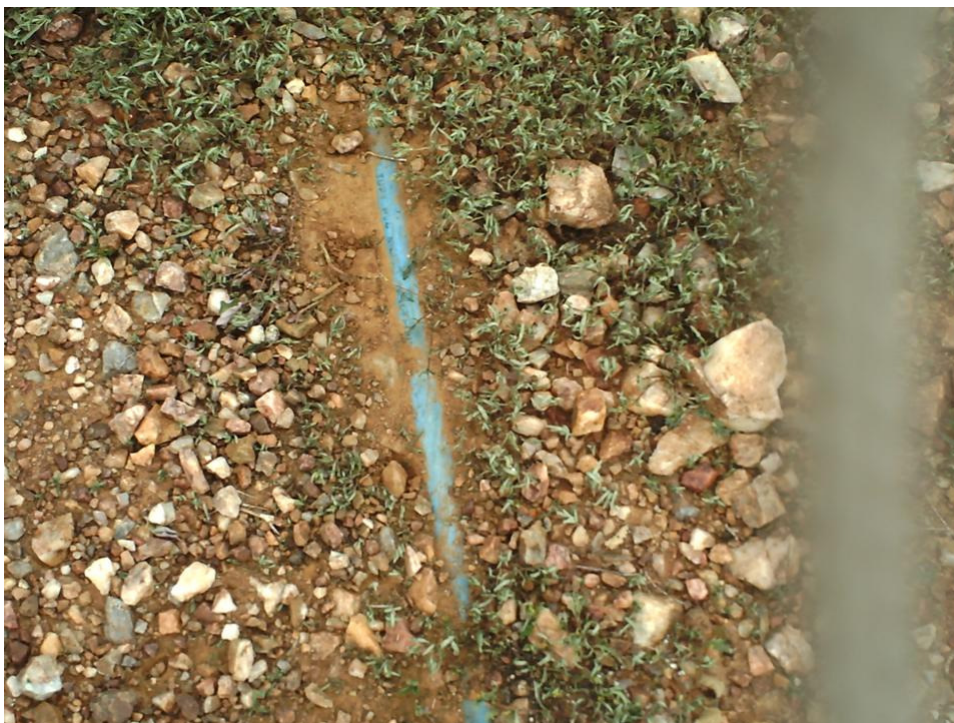
Foto 5.1 – Adutora de DN 75 mm (ponto GPS 32).
