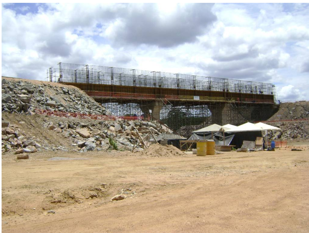
Foto 1 – Vista geral do Aqueduto Logradouro, com a laje de fundo concretada.
