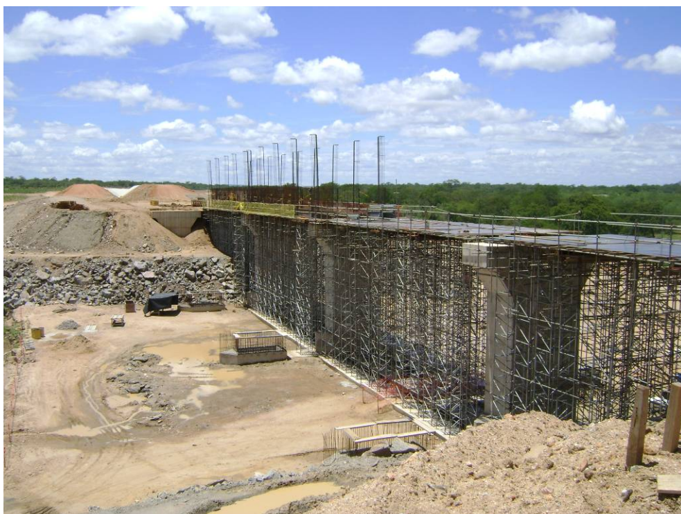
Foto 2 – Vista da montagem do cimbramento e da armadura da laje de fundo do Aqueduto Saco da Serra.
