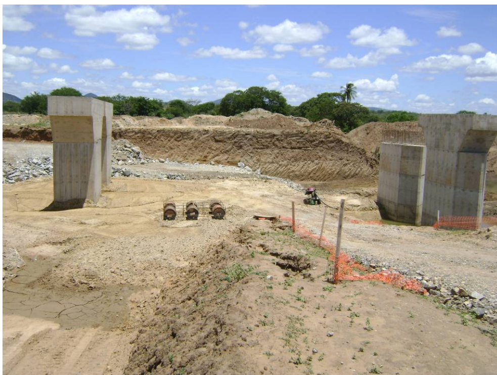
Foto 4 – Vista das obras do Aqueduto Terra Nova, observando-se 4 pilares concretados e um dos aterros de encontro, parcialmente executado.
