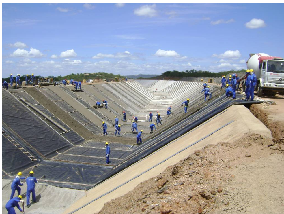
Foto 5 – Vista geral das obras do canal CN-09, observando-se o assentamento da geomembrana e a execução da concretagem das paredes e do fundo.
