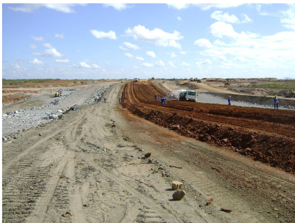
Foto 6 – Aspecto geral do início do alteamento do maciço compactado da Barragem de Serra do Livramento.
