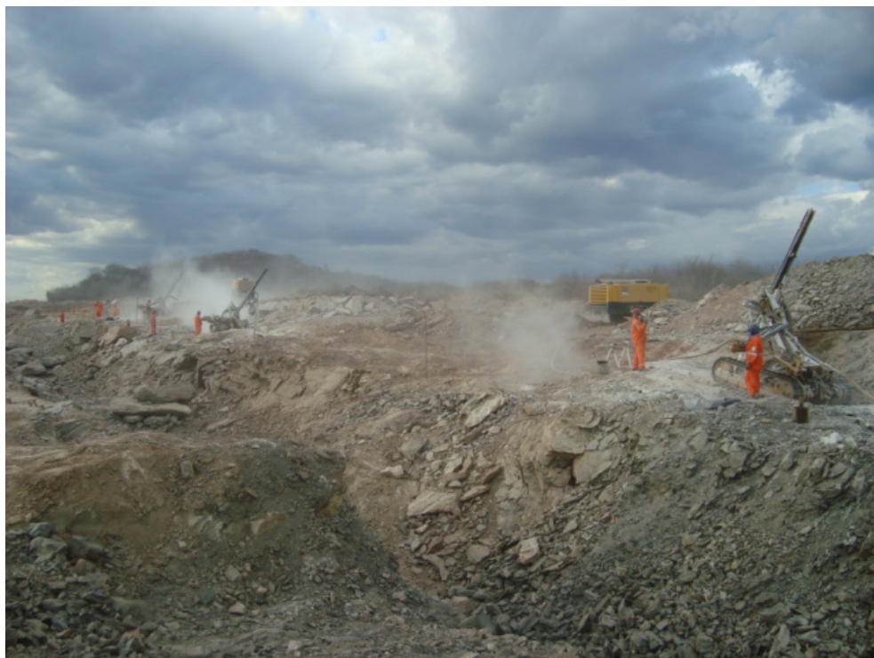
Foto 5 – Aspecto geral das perfurações para as escavações em material de 3ª categoria (maciço rochoso) do canal CN-14.
