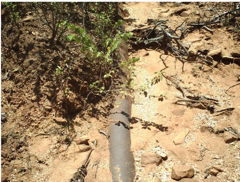
Foto 2.1 – Adutora de ferro dúctil de DN 200 mm.
