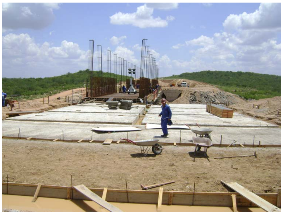
Foto 1 – Vista da concretagem da laje de fundo do Aqueduto Logradouro.
