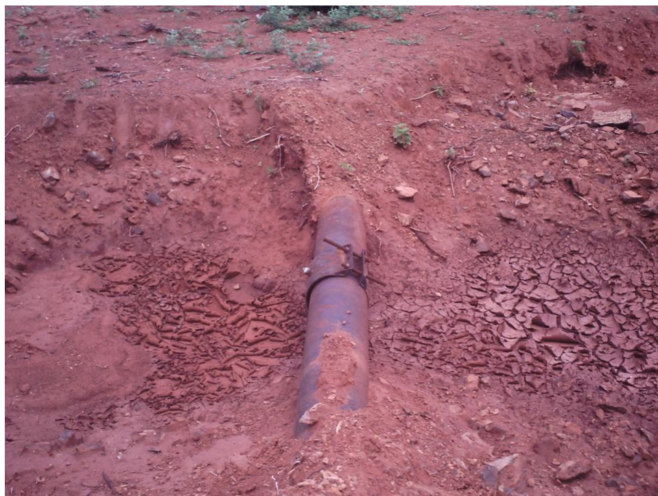
Foto 1.1 – Adutora de ferro dúctil de DN 200 mm.
