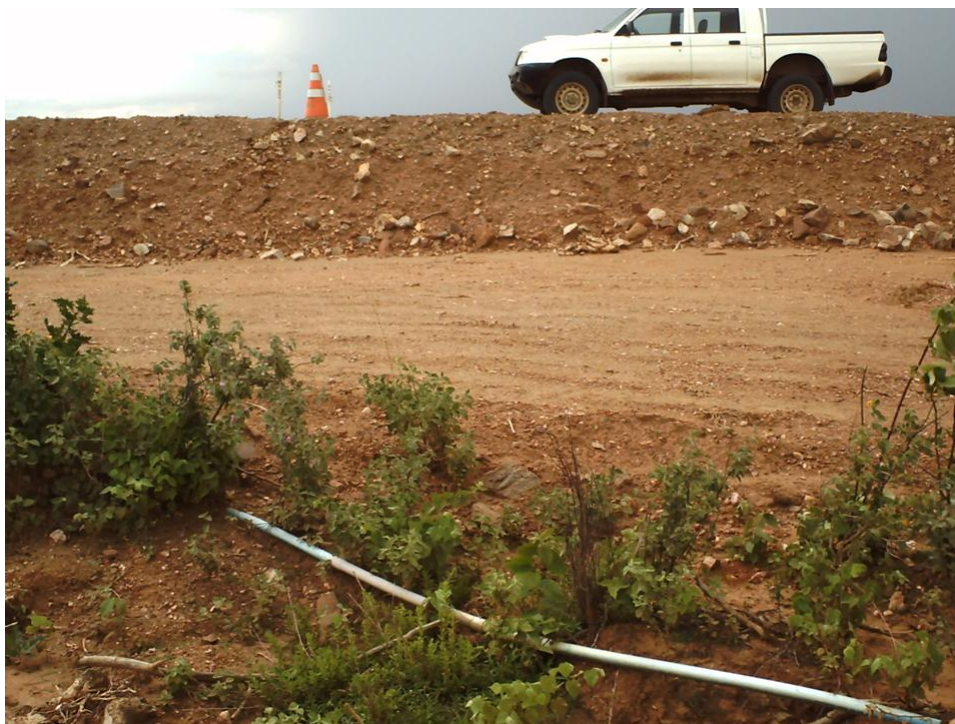
Foto 3.8 – Passagem da adutora DN 75 mm – Trecho em aterro do canal CN-11.
