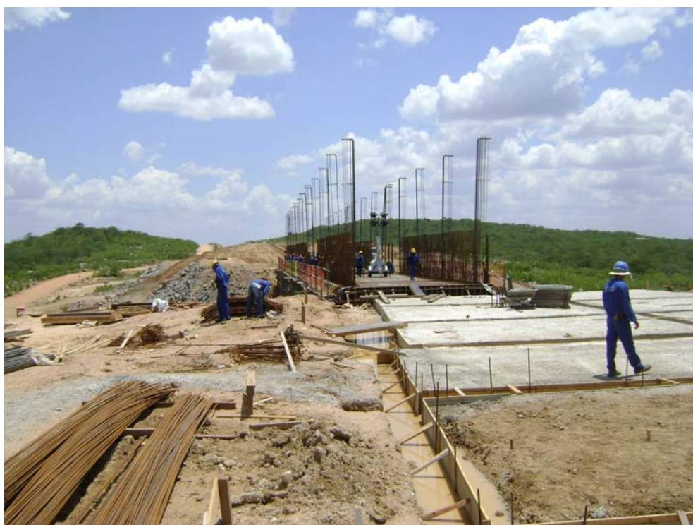
Foto 2 – Vista da montagem do cimbramento e armadura da laje de fundo do Aqueduto Saco da Serra.
