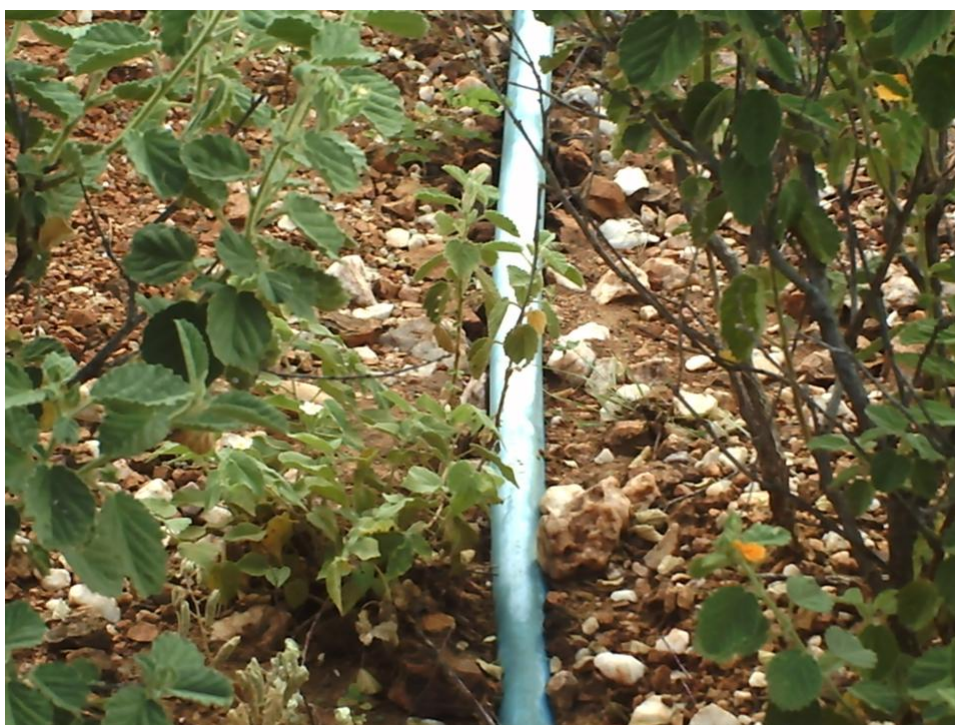
Foto 3.4 – Ramal DN 50 mm (“capeado”) que atende as casas.
