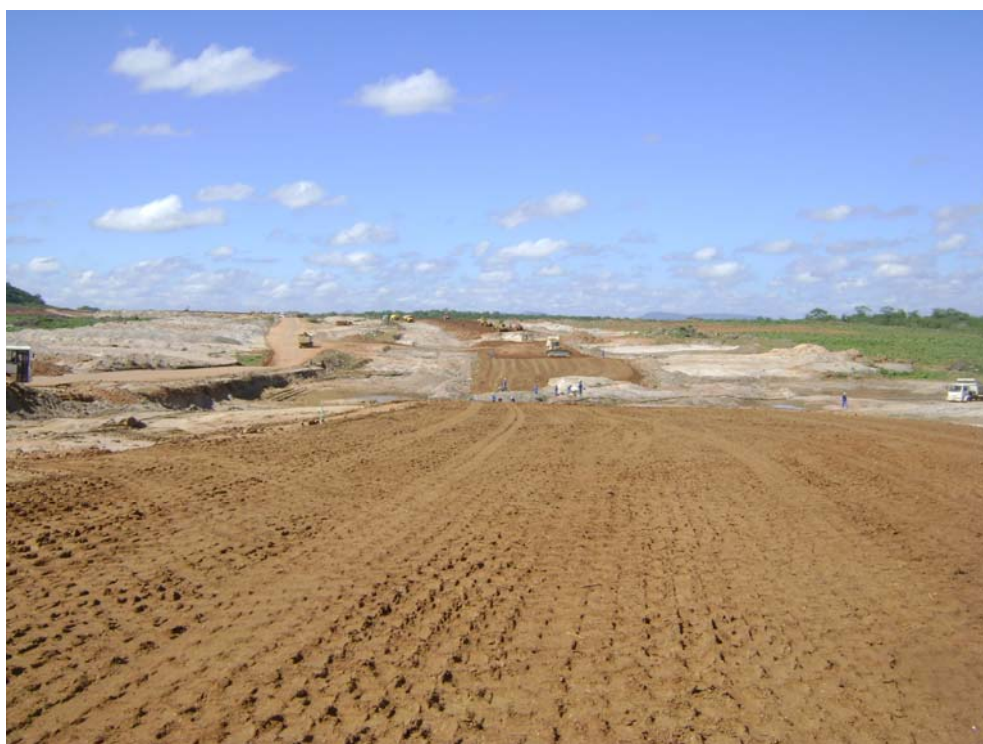
Foto 4 – Aspecto geral do início do alteamento do maciço compactado da Barragem de Serra do Livramento.
