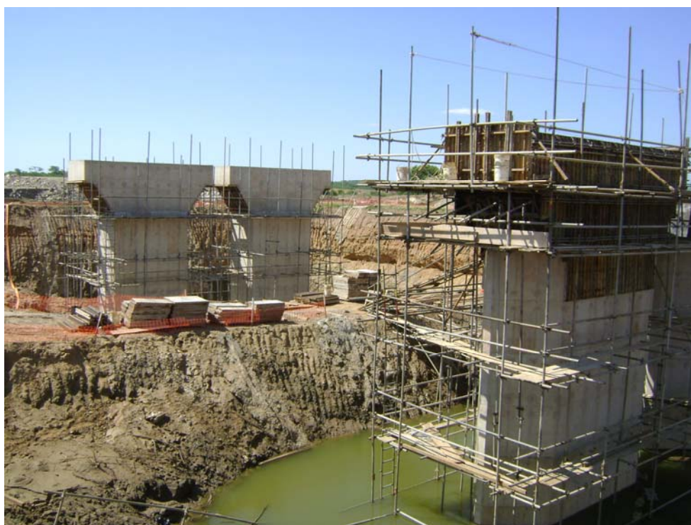
Foto 3 – Vista geral da concretagem dos pilares do Aqueduto Terra Nova. Em primeiro plano, à direita, os pilares P5 e P6. No centro da foto estão os pilares P3 e P4.
