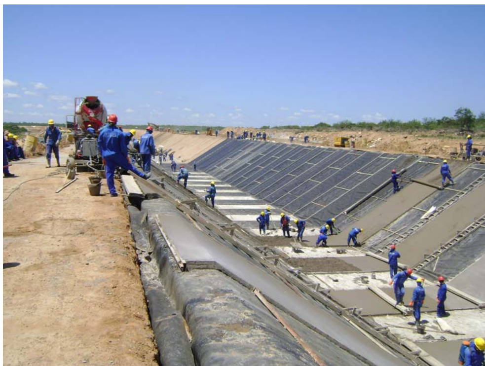
Foto 1 – Vista da concretagem do revestimento do canal CN-04.
