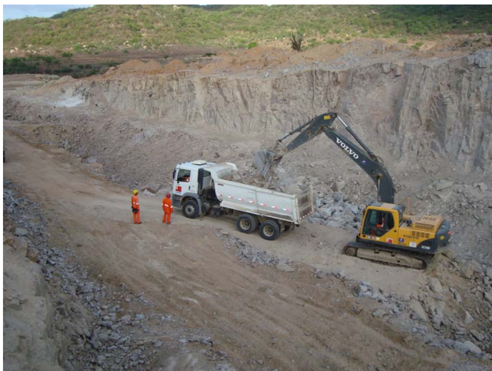
Foto 6 – Aspecto geral das escavações do canal CN-14 em material de 3ª categoria.
