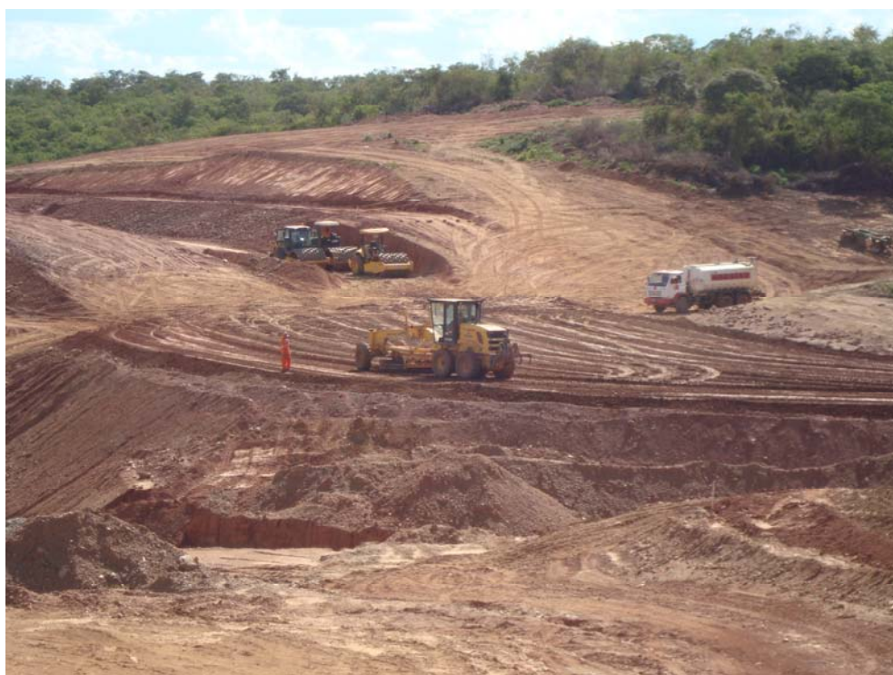
Foto 5 – Aspecto geral da execução de aterro do canal CN-14 com material de 1ª categoria.
