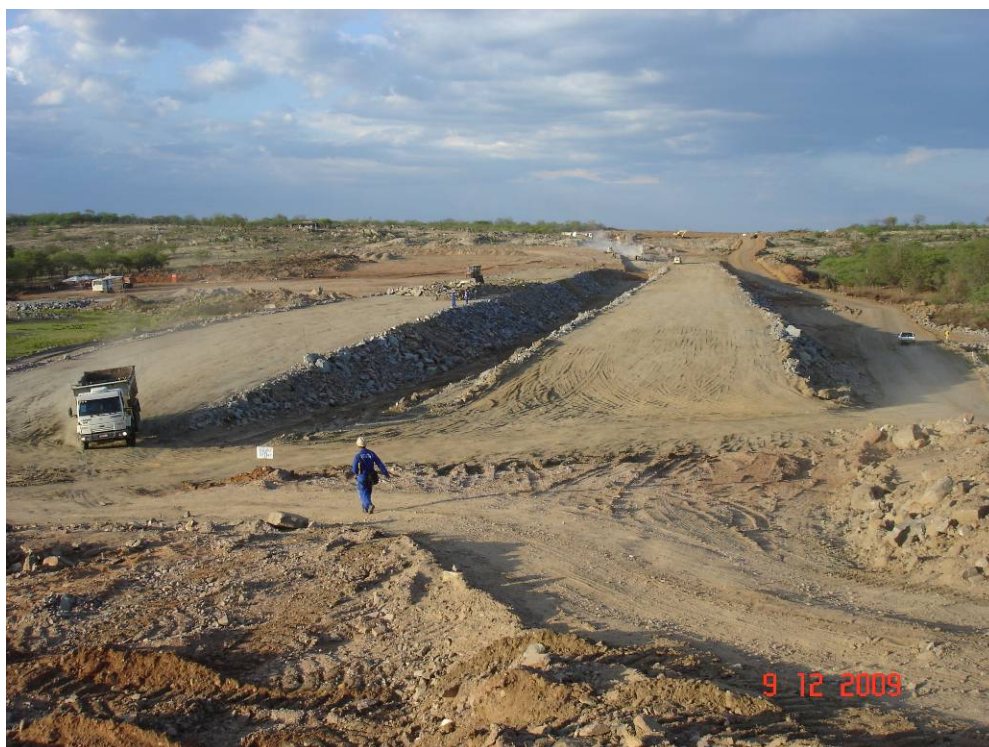
Foto 5 – Vista geral do canal CN-07, nas imediações da estaca 2250, com as obras de terraplenagem em andamento. Nesse local ocorre a interferência com um braço do Rio Terra Nova.
