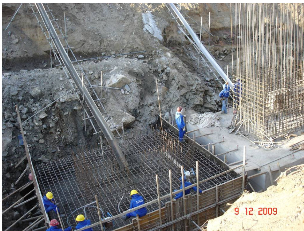
Foto 4 – Aspecto da concretagem das fundações dos pilares P5 e P6, do Aqueduto Terra Nova.
