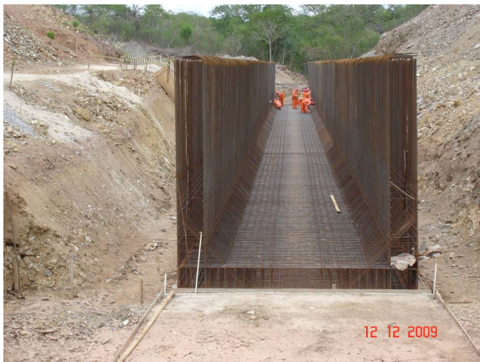
Foto 7 – Aspecto geral da montagem das armaduras do bueiro B-045 do canal CN-14.
