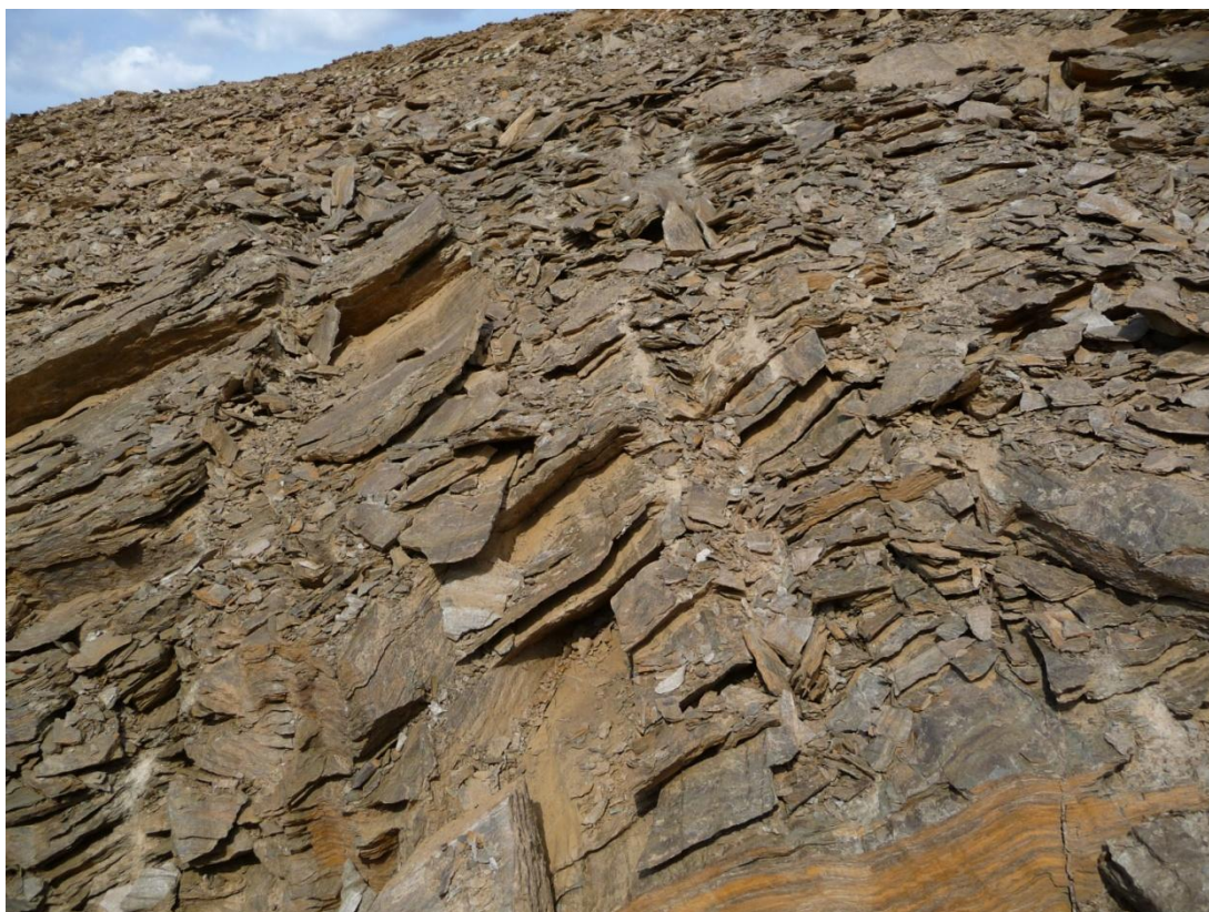
Foto 06 – Canal CN-14 – Detalhe do talude em filito.
