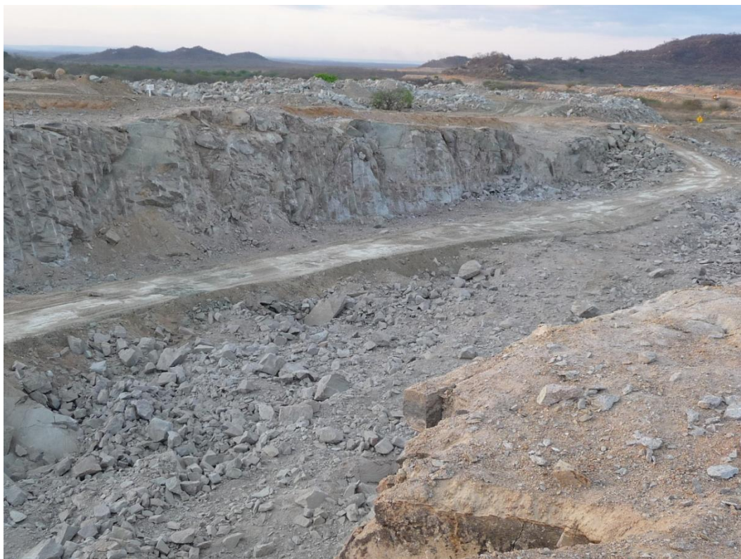
Foto 01 – Canal CN-14 – Vista do trecho inicial, escavado em rocha.
