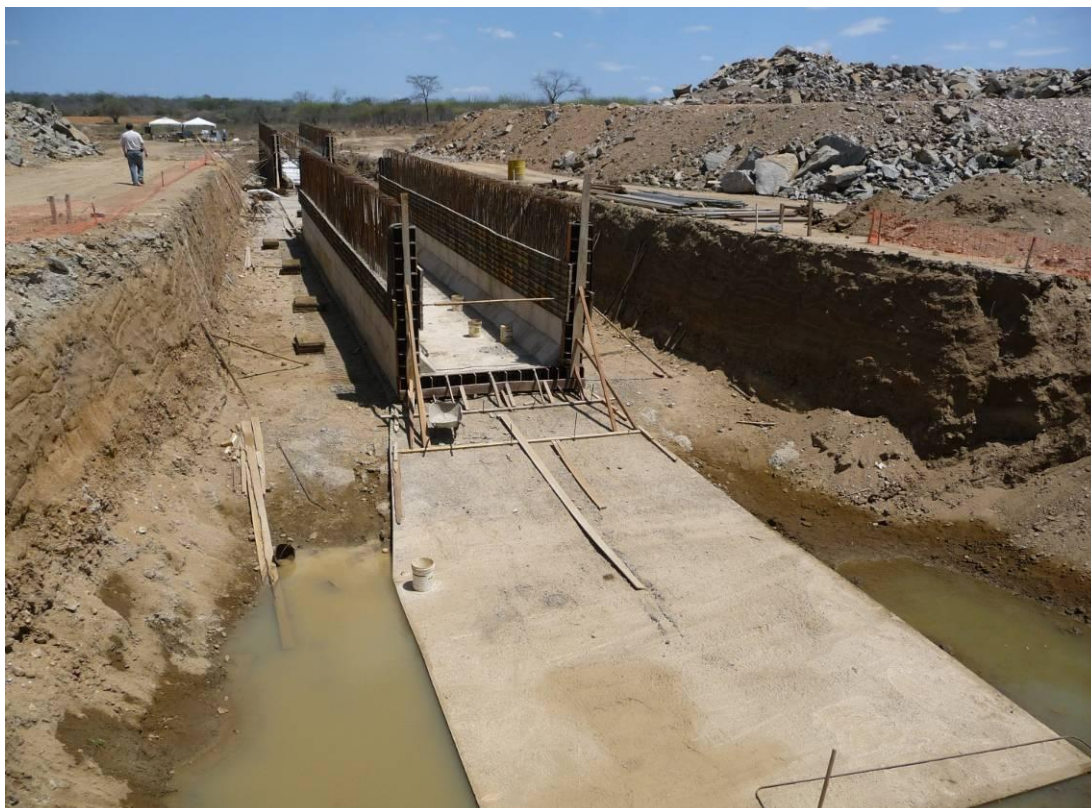
Foto 11 – Canal CN-05 – Detalhe da execução do bueiro B002, moldado “in loco”.
