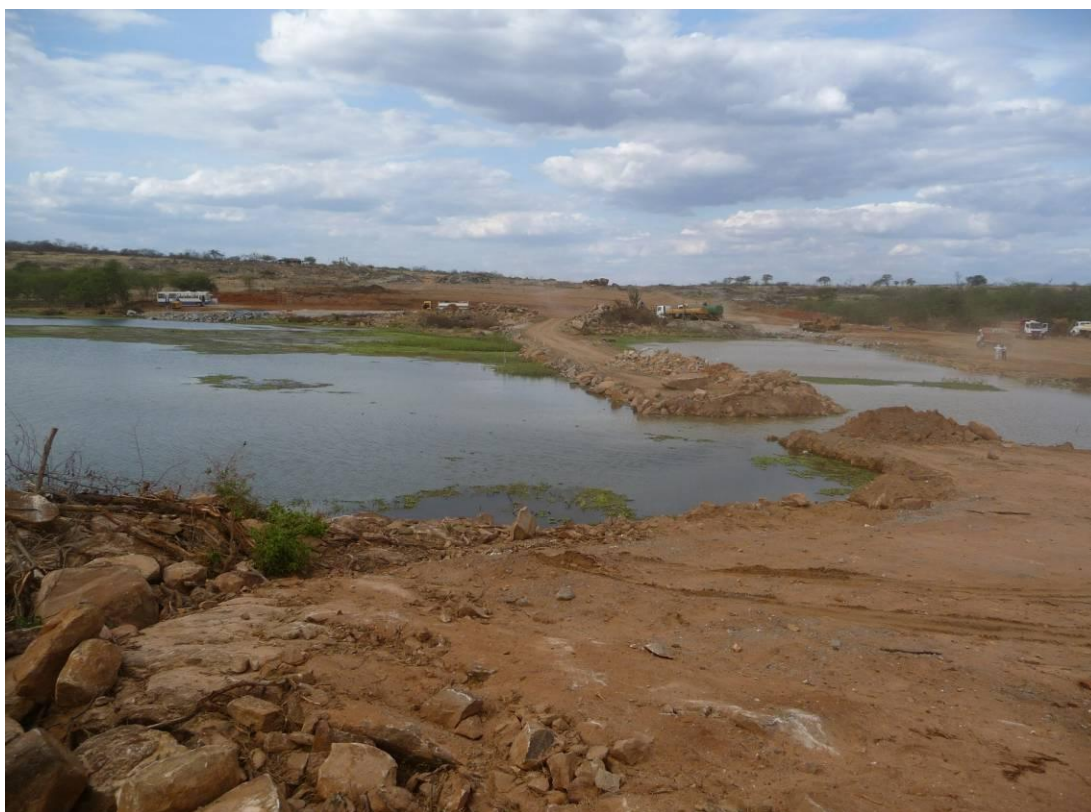
Foto 16 – Canal CN-07 – Aspecto do cordão de enrocamento lançado dentro d'água no mesmo local.
