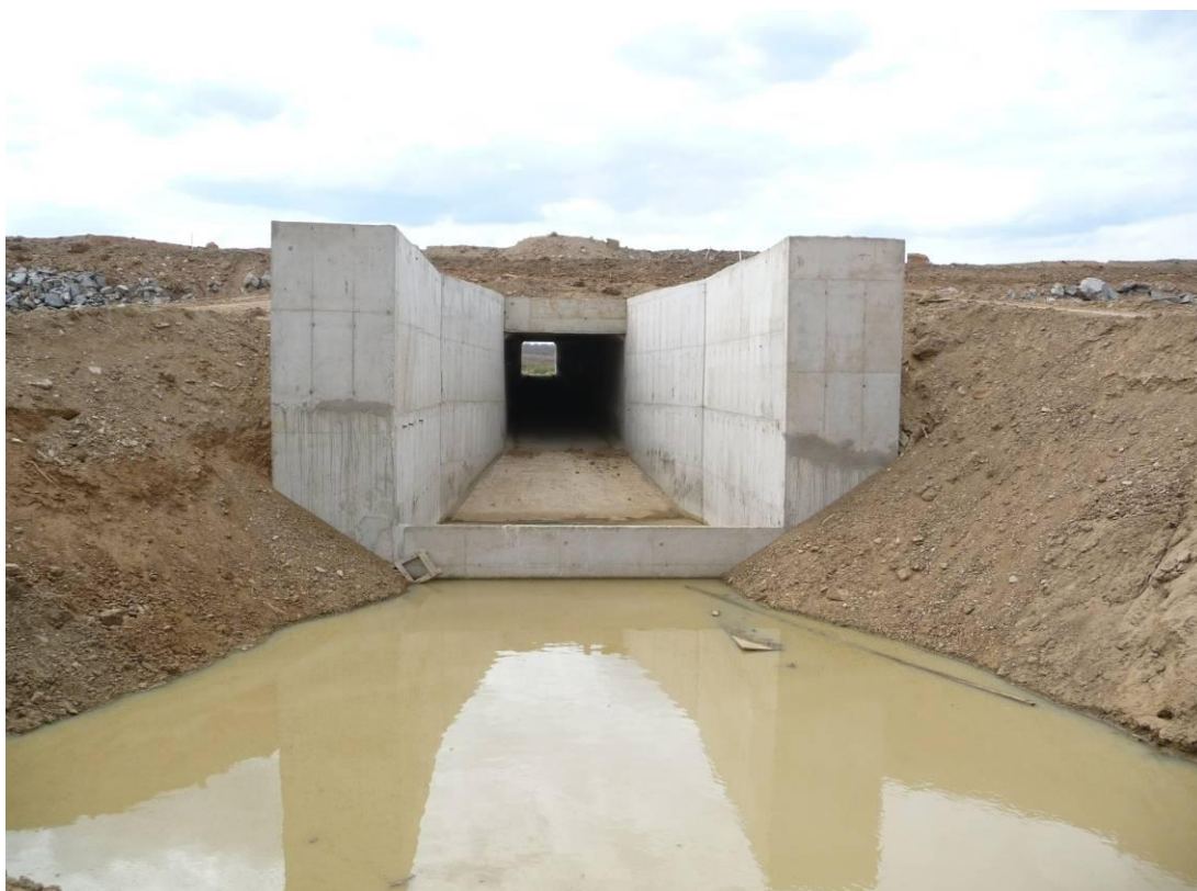
Foto 10 – Canal CN-04 – Vista do bueiro B004 moldado “in loco”.
