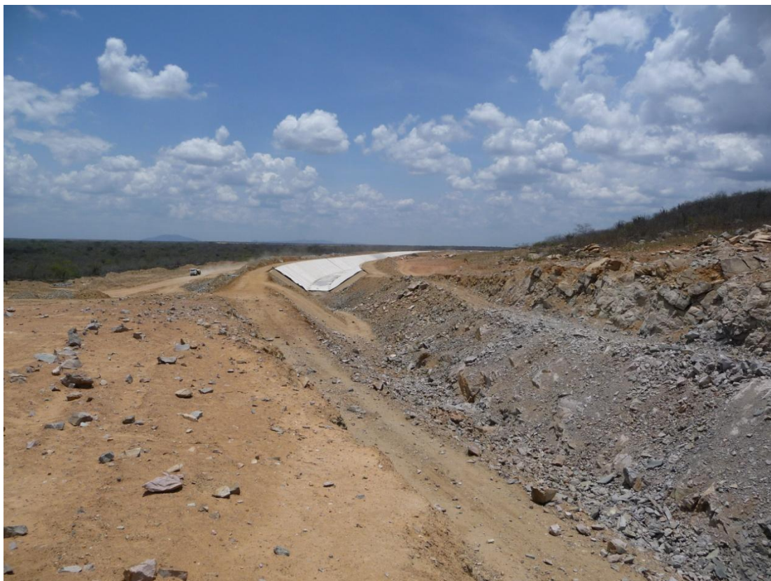
Foto 05 - Canal CN-02 – Vista da transição de trecho em aterro para corte.
