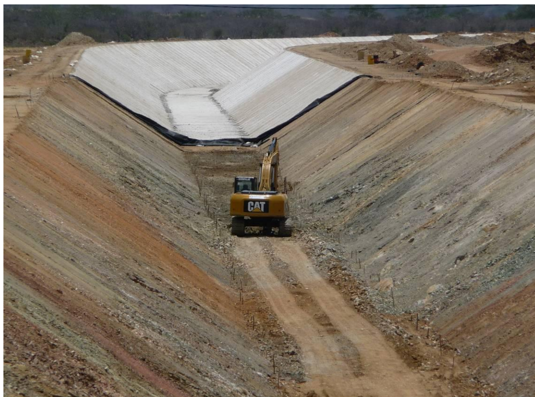
Foto 06 – Canal CN-03 – Detalhe da interrupção do trecho revestido em concreto.
