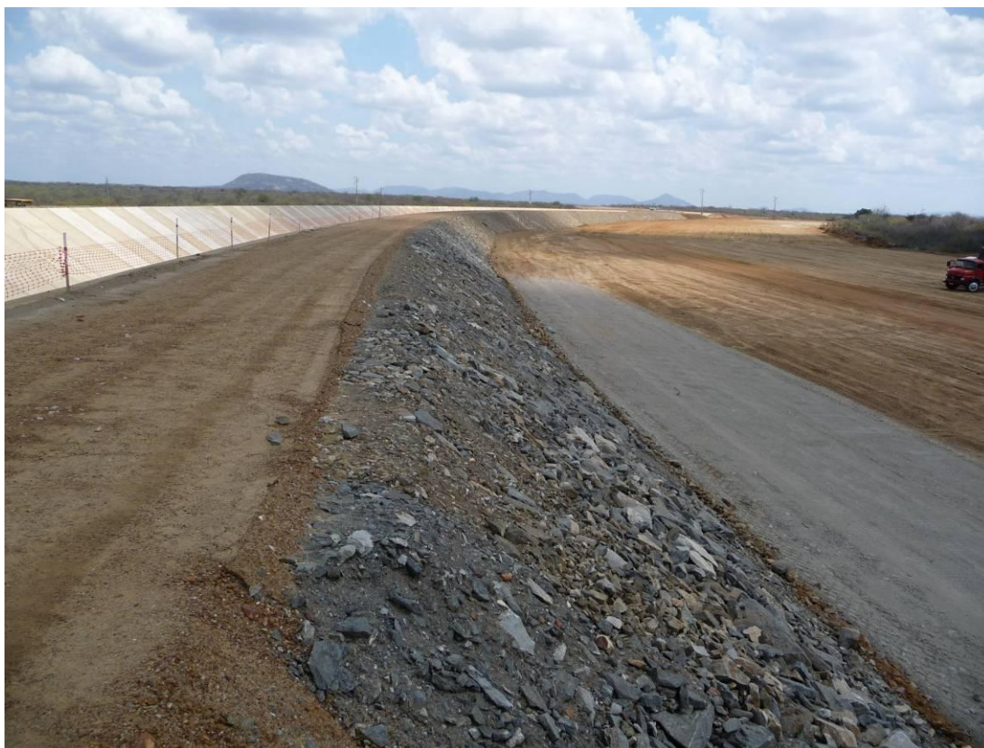
Foto 02 – Canal CN-01 – Vista da proteção superficial do talude externo com enrocamento.
