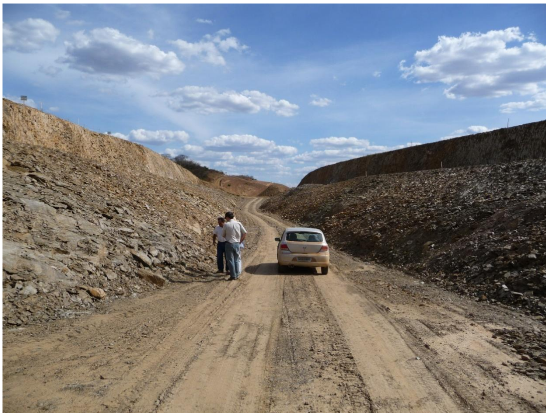
Foto 05 – Canal CN-14 – Vista geral de trecho escavado em filito.
