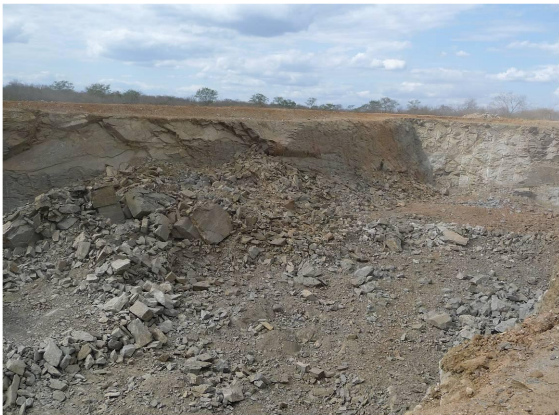
Foto 09 – Túnel Angico – Aspecto da escavação em rocha na região do emboque.
