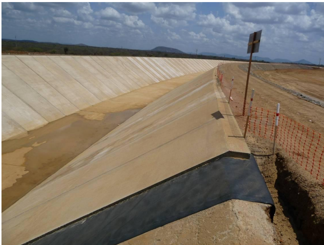
Foto 01 – Canal CN-01 – Vista do revestimento interno com geomembrana e concreto.
