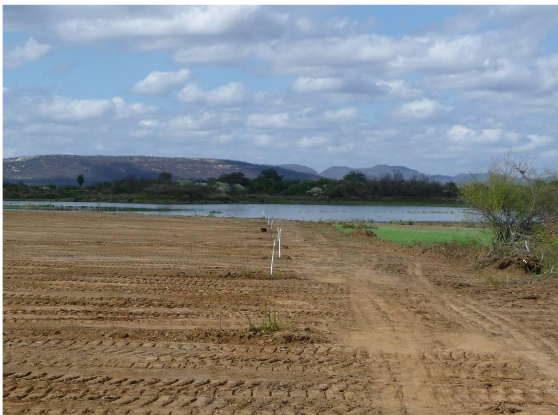
Foto 18 – Canal CN-08 – Vista do açude interceptado pelo traçado do canal. Observar marcação do eixo (estacas brancas).
