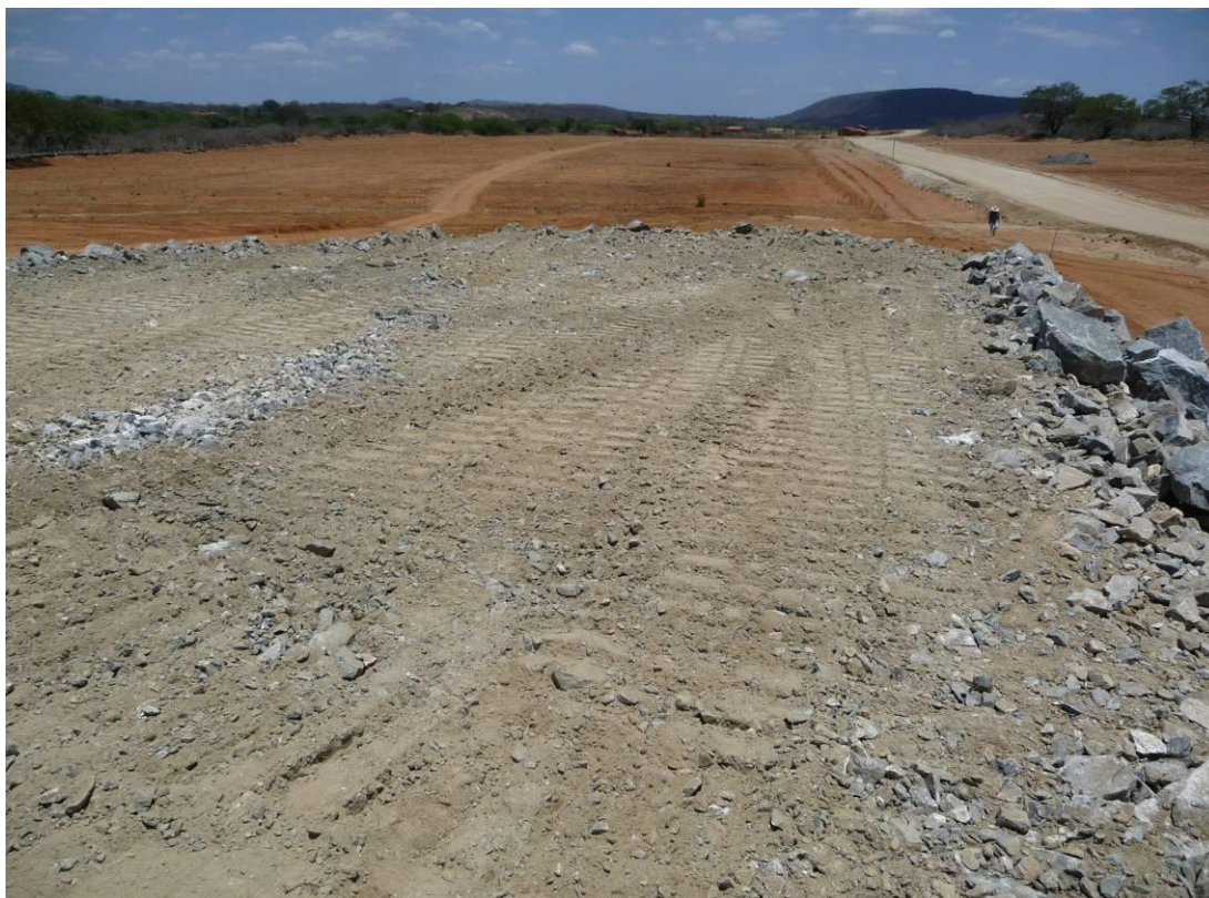
Foto 13 – Canal CN-06 – Execução da base do aterro em enrocamento compactado.
