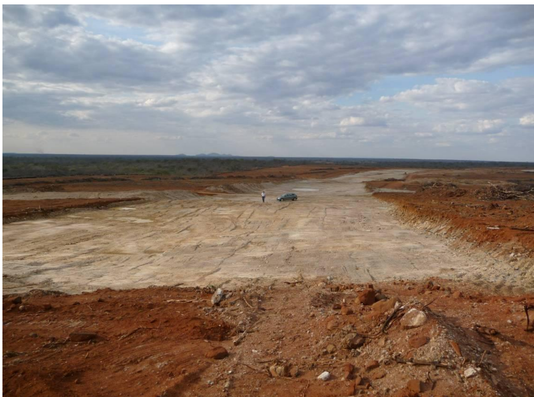
Foto 22 – Barragem Serra do Livramento – Aspecto geral da escavação e preparo das fundações do maciço da barragem.
