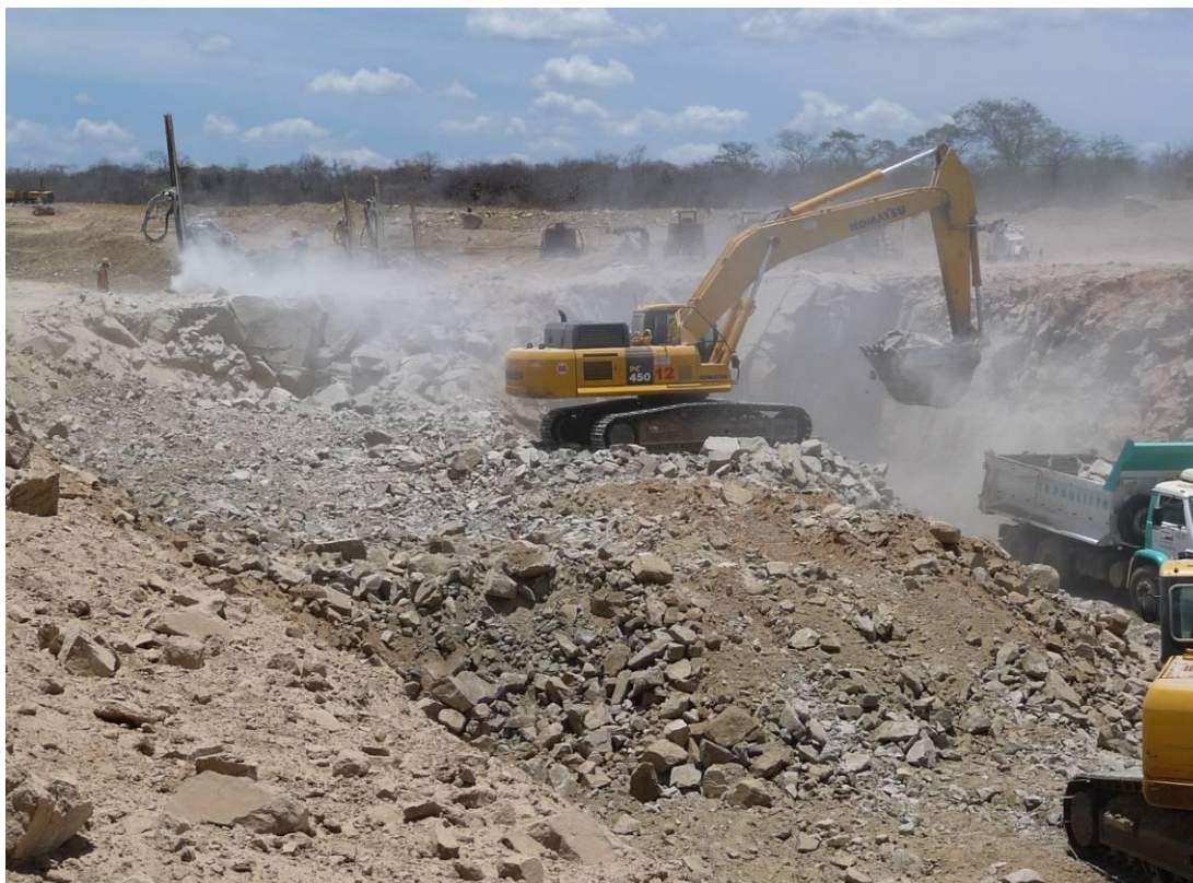
Foto 27 – Canal CN-12 – Aspectos da escavação em rocha.
