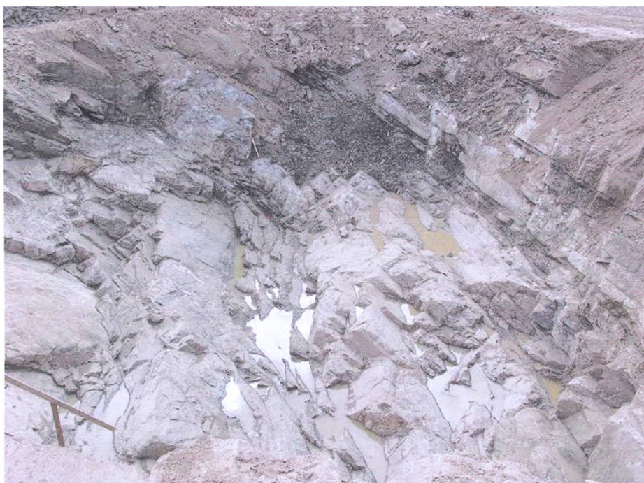
Foto 2 – Situação do maciço rochoso local: gnaiss com estruturação oblíqua à superfície. Situação do apoio dos pilares P7-P8 imediatamente antes da concretagem.
