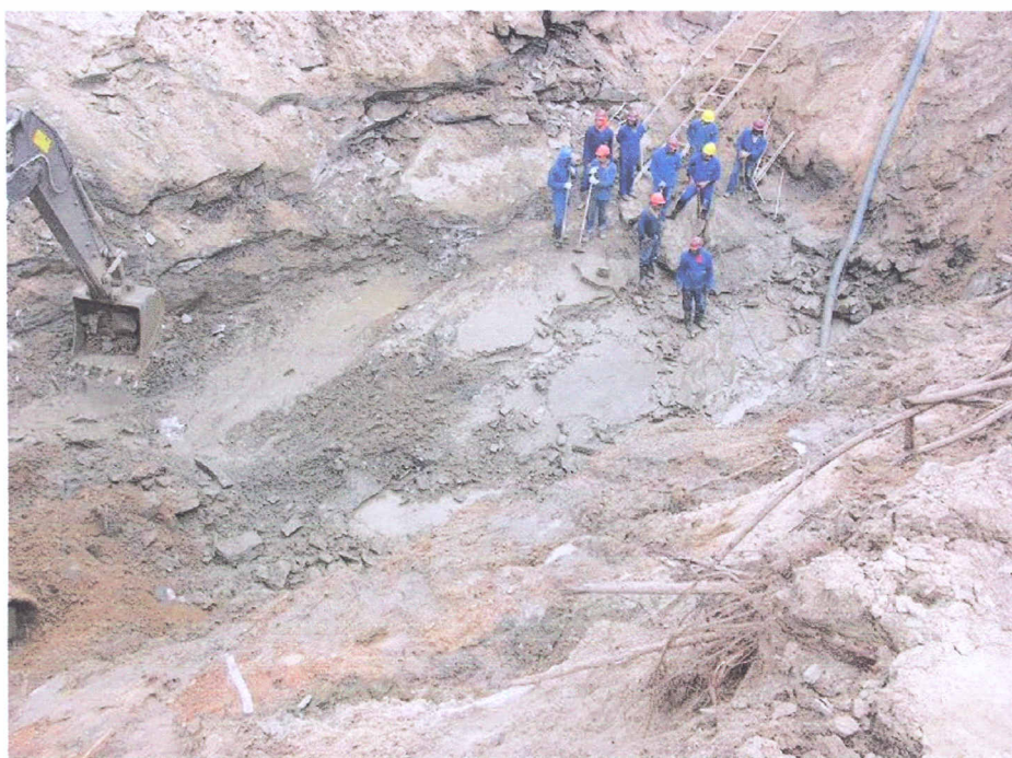
Foto 5 – Apoio dos pilares P3-P4 ao término de nossa visita. A fragmentação superficial da rocha é resultado da atividade das máquinas no local.
