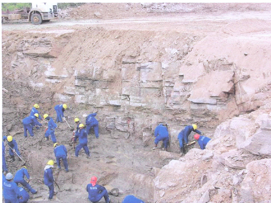
Foto 7 – Intenso fraturamento do maciço rochoso: nesta imagem, realce das fraturas sub-verticais. Apoio dos pilares P7-P8.
