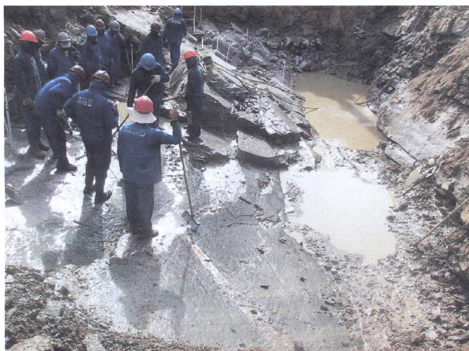
Foto 6 – Apoio dos pilares P3-P4 após nossa visita e recomendações de prosseguimento da escavação.
