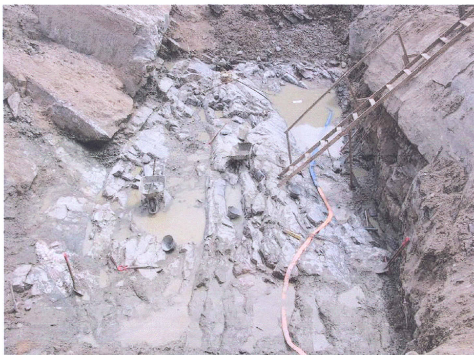
Foto 3 – Apoio dos pilares P5-P6.
