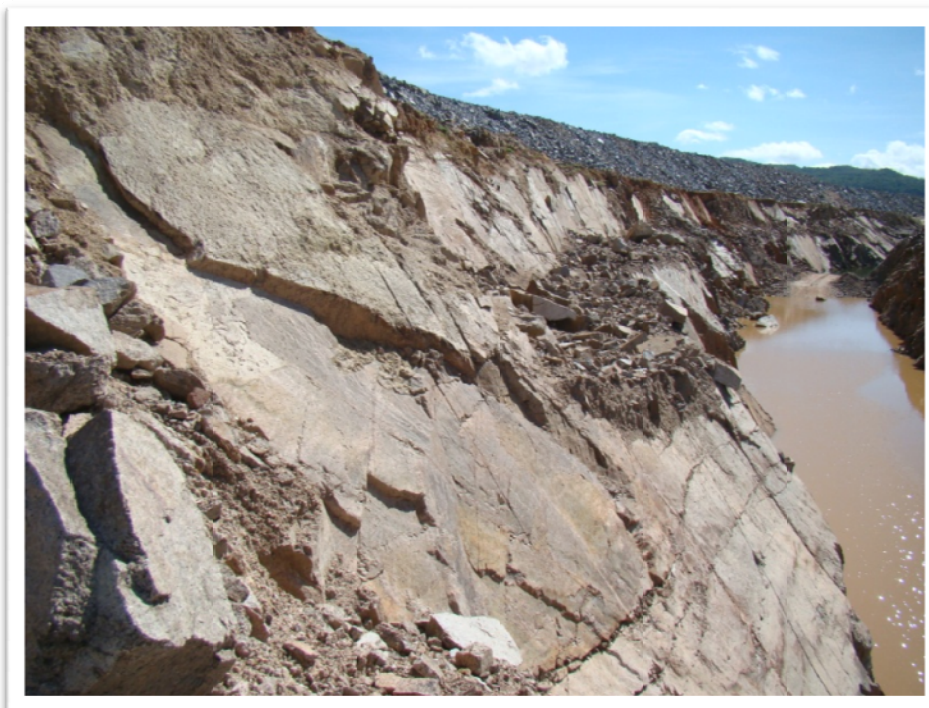
Foto 1: E-3870 LE – Taludes definidos pela fratura 160/55 (uma variação da F2). São visíveis fraturas sub-horizontais, mas não foi possível medir atitude devido à grande quantidade de água.
