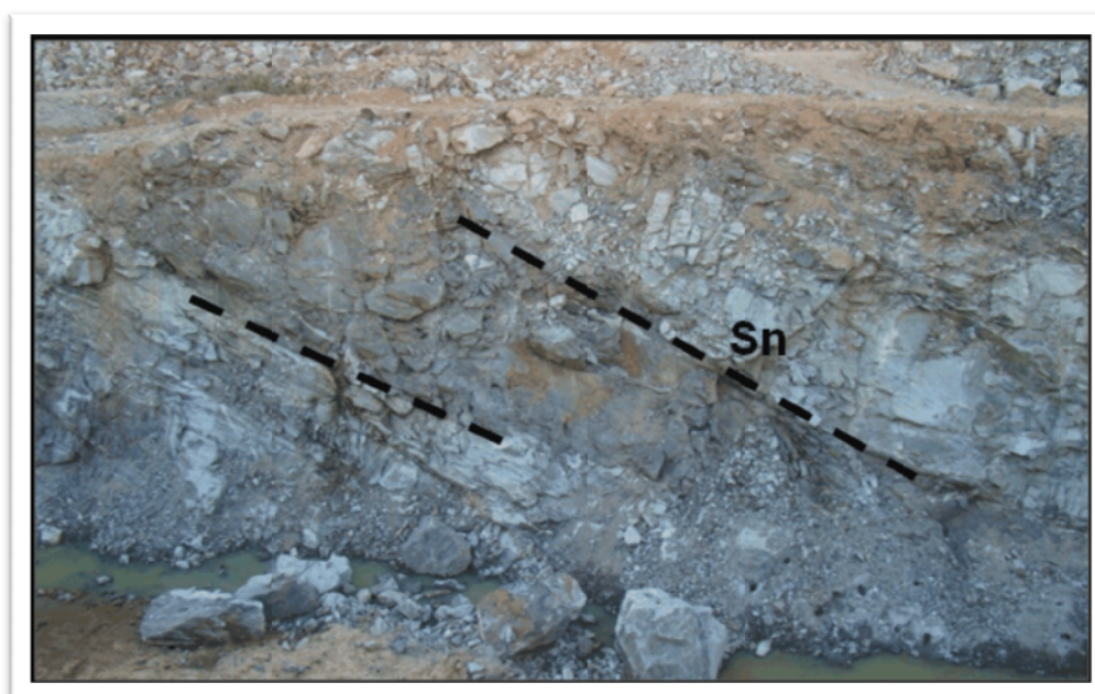
Foto 16: E 3964 LE – Talude 115/80 e uma família de fratura definida pela foliação Sn=350/40.
