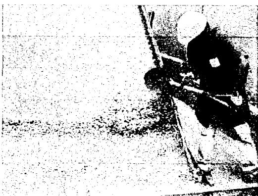
Foto 7 - Lançamento com o emprego de ferramentas manuais
