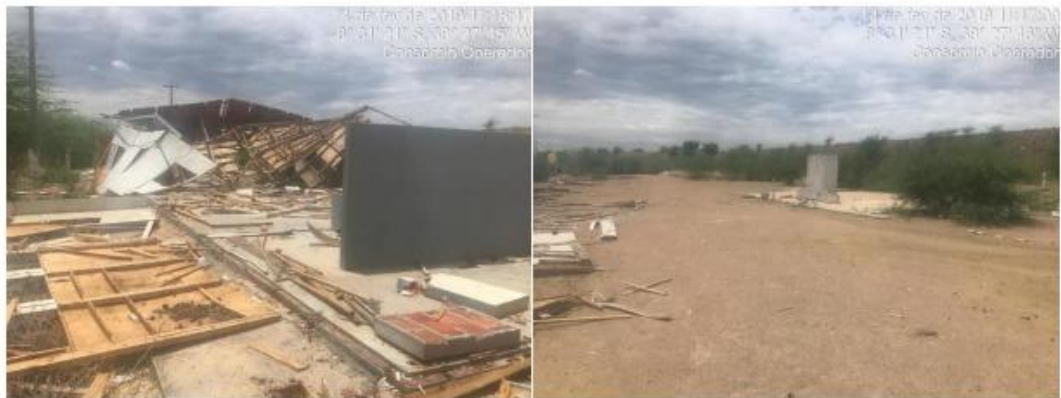
Canteiro META 1N – Cabrobó-PE
