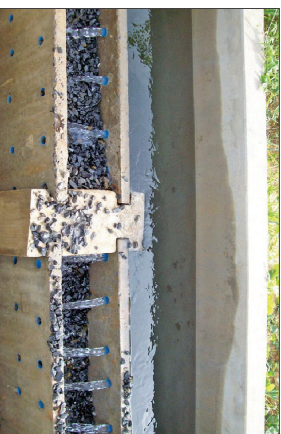
SISTEMA DE FILTRAGEM COM BRITAS
