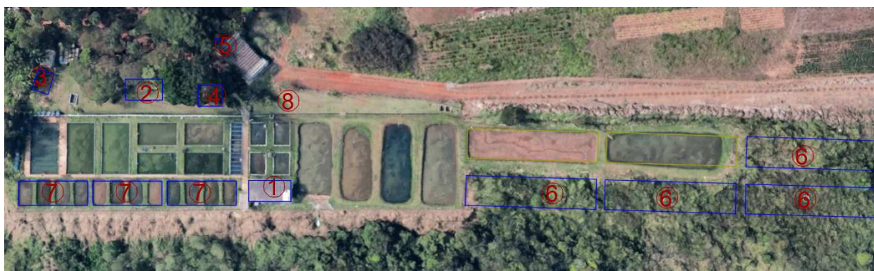
Imagem da área que sofrerá as intervenções.
