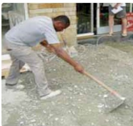
Foto 03 – Espalhamento da brita e compactação da base
