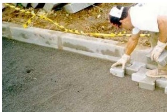
Foto 05/06/07 – Camada de assentamento
