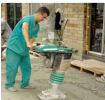
Foto 03 – Espalhamento da brita e compactação da base
