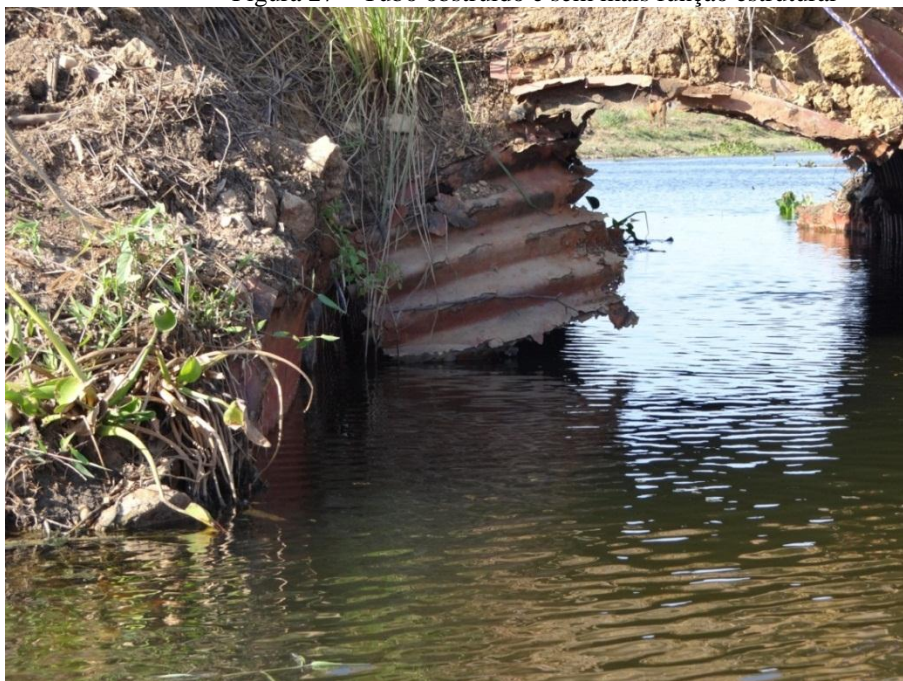
Figura 27 – Tubo obstruído e sem mais função estrutural
