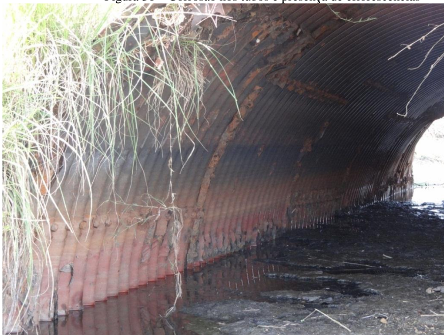
Figura 31 – Corrosão nos tubos e presença de eflorescências
