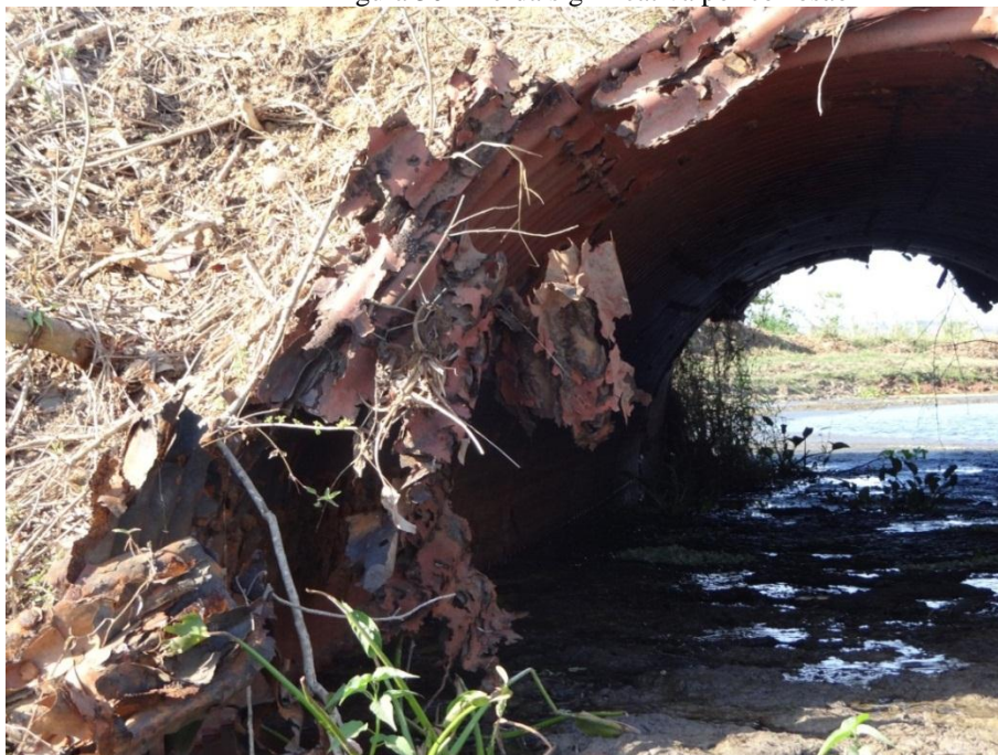
Figura 30 – Perda significativa por corrosão
