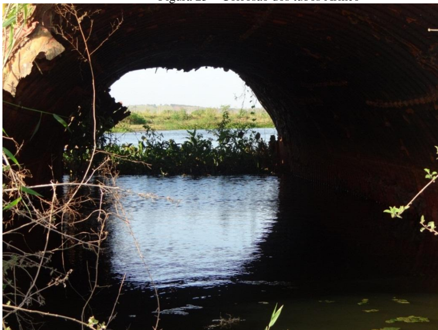
Figura 25 – Corrosão dos tubos Armco
