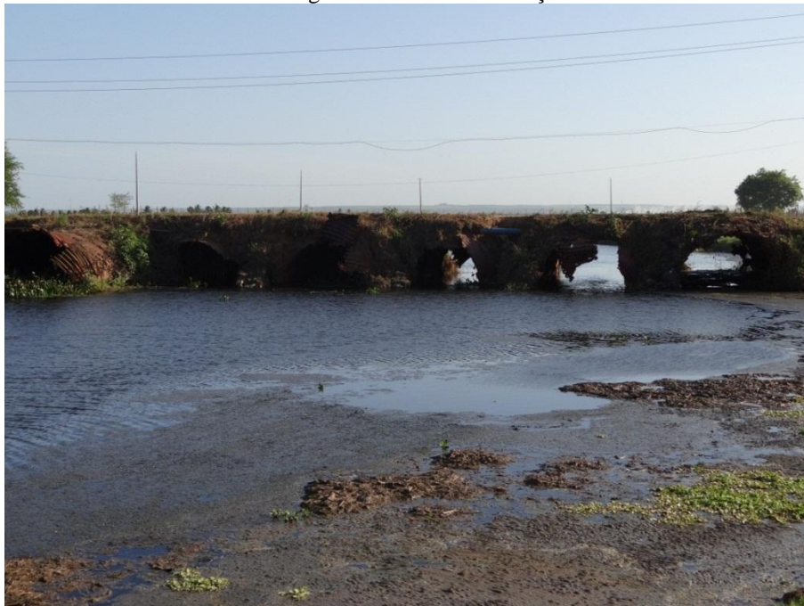
Figura 36 – Tubos com seção obstruída
