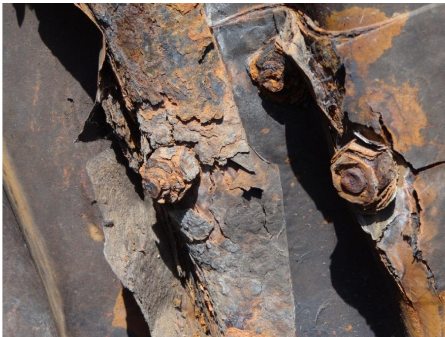
Figura 22 – Alto grau de corrosão nas ligações
