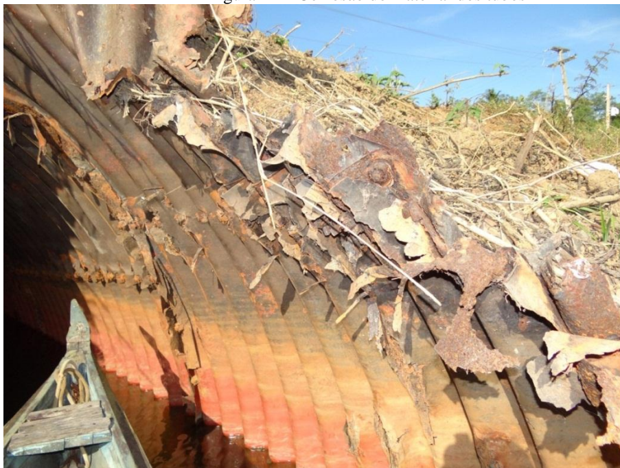
Figura 24 – Corrosão do material dos tubos
