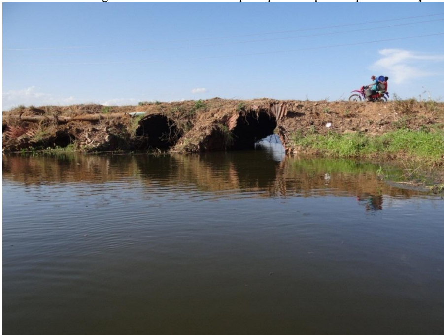
Figura 21 – Tubo obstruído pela queda da parte superior da seção
