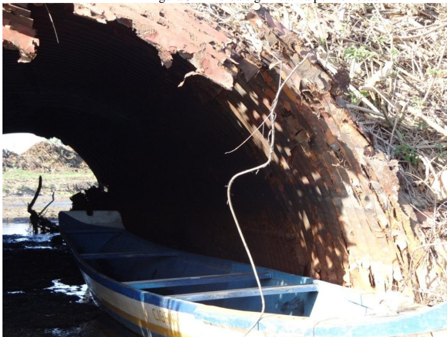
Figura 32 – Perda significativa por corrosão
