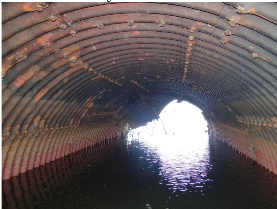
Figura 23 – Corrosão dos tubos Armco
