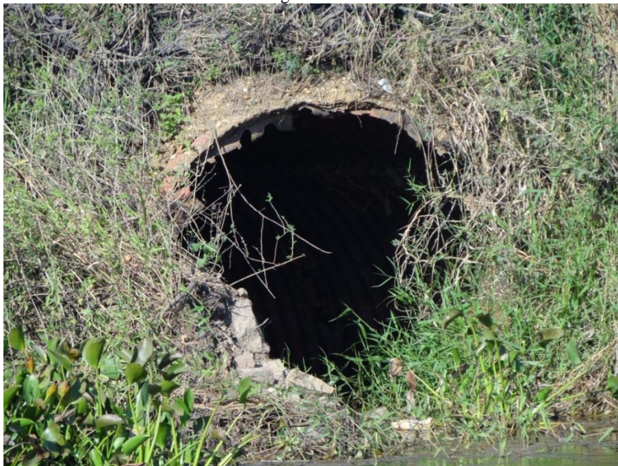
Figura 19 – Tubo obstruído
