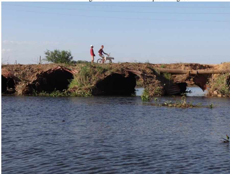
Figura 34 – Tubo com seção esmagada
