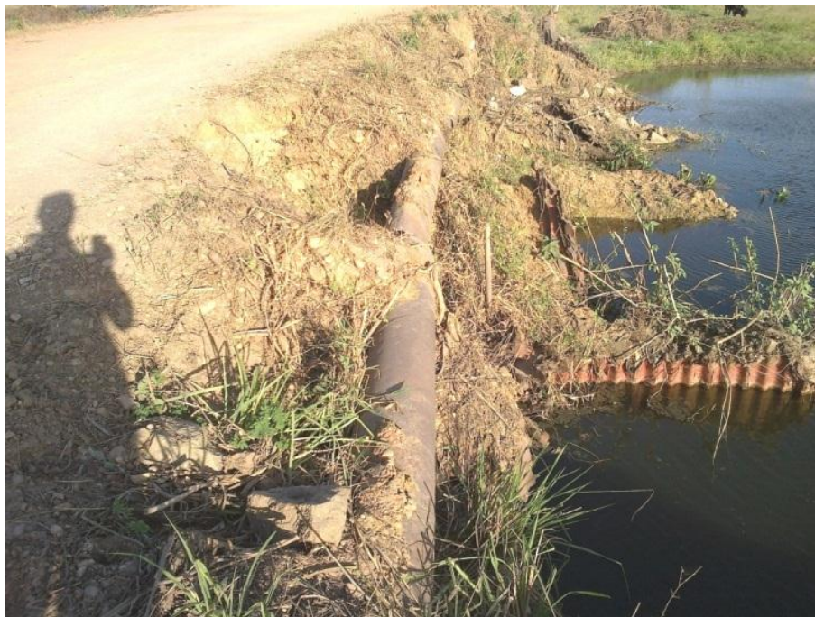
Figura 12 – Tubulação aparente
