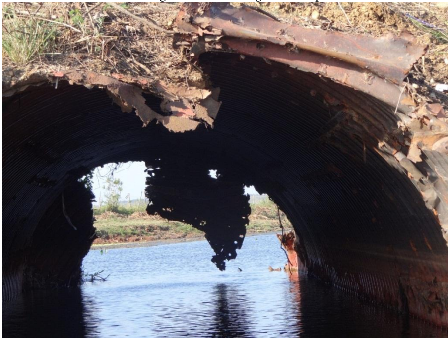
Figura 28 – Perda significativa por corrosão
