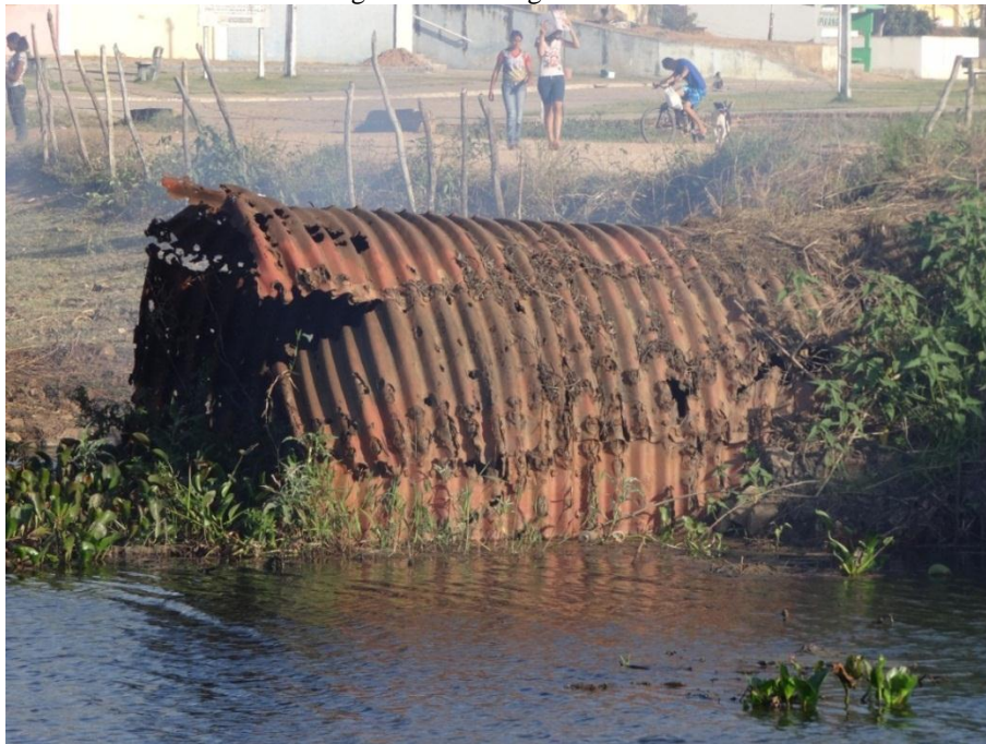
Figura 38 – Alto grau de corrosão nos tubos
