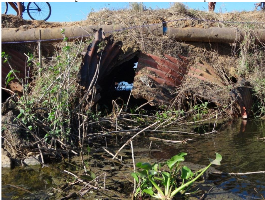
Figura 26 – Tubo obstruído e sem mais função estrutural
