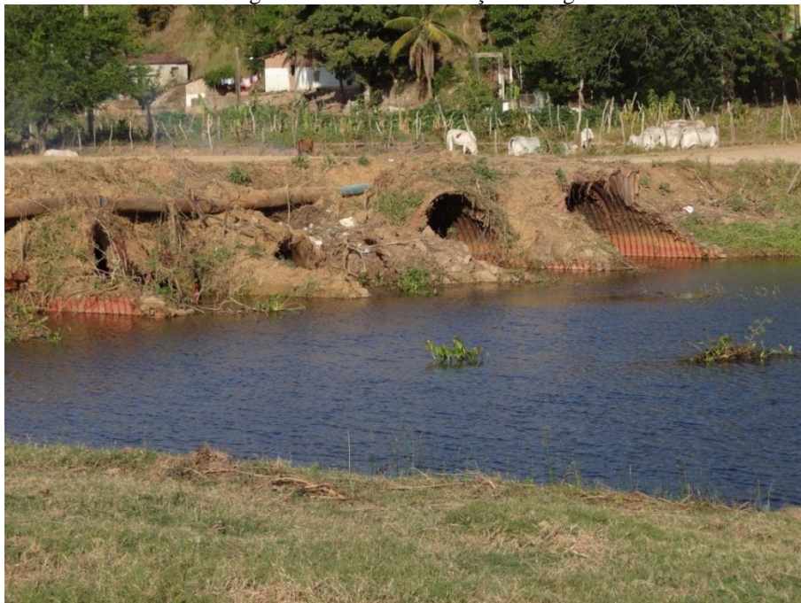
Figura 39 – Tubos com seção esmagada e obstruída
