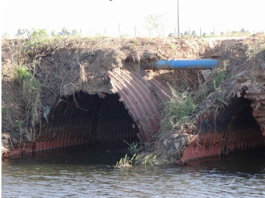
Figura 37 – Assoreamento de terra
