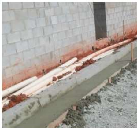
Figura 02 – Execução de sarjeta moldada in loco.
