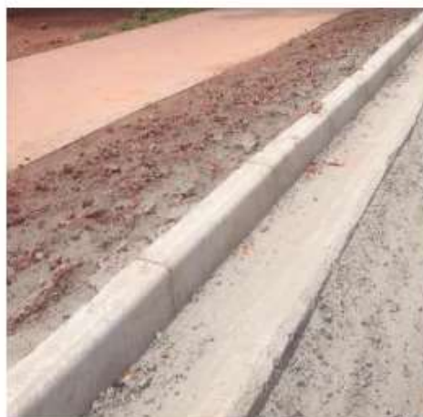
Figura 01 – Execução de Meio fio pré-moldado.
