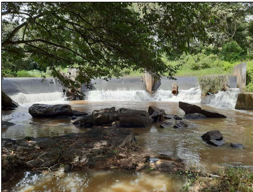
Figura 15 - Barragem de Nível no local da Tomada D'água.
