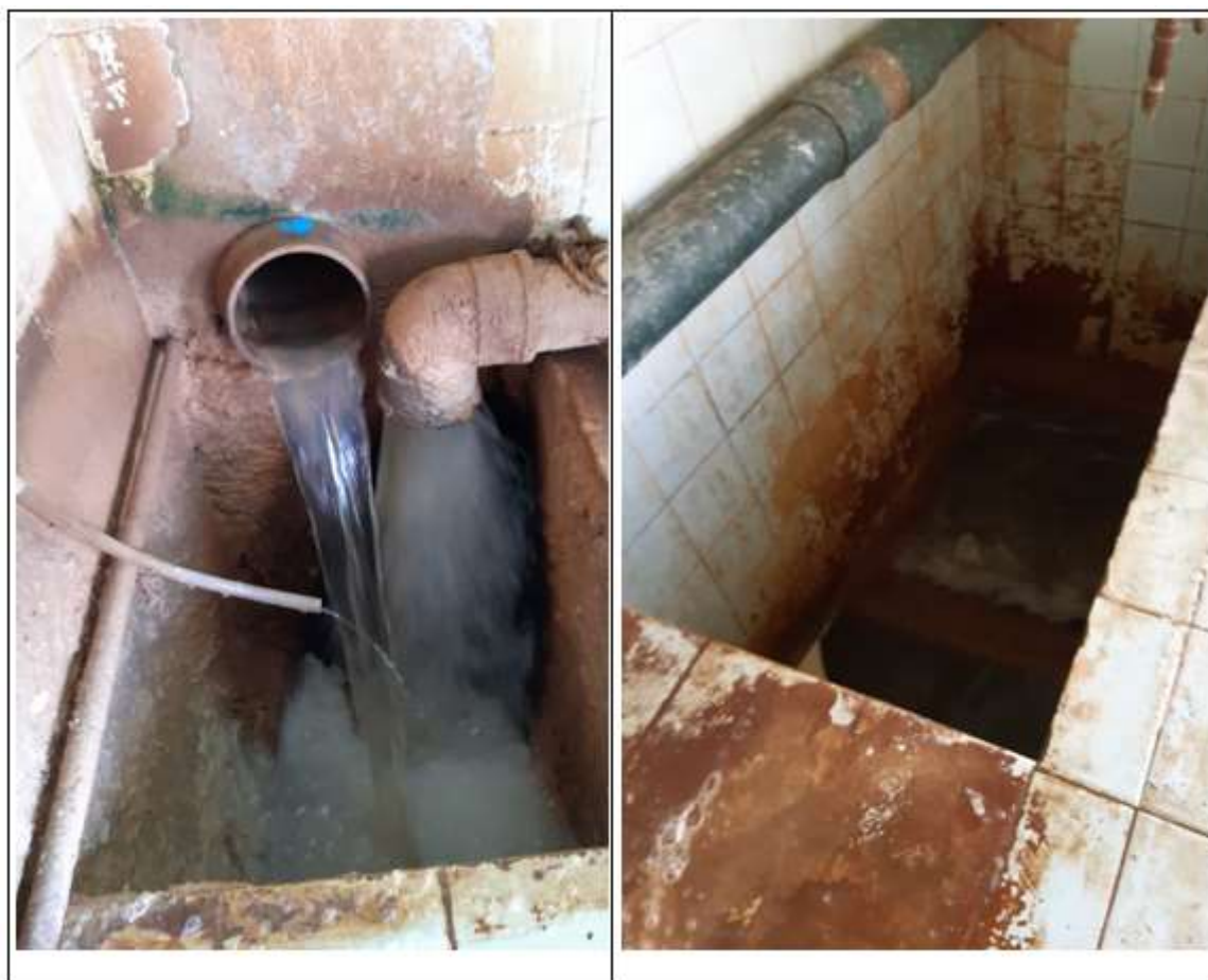
Figura 1 - Chegada das Adutoras no Bloco Hidráulico. A tubulação da Esquerda, vem da Captação do Rio Jibóia, já a Captação da Direita, vem de uma pequena barragem na Fazenda Constanópolis, para reforço, visto que a Adutora que vem do Rio Jibóia, está muito danificada, diminuindo a vazão.
