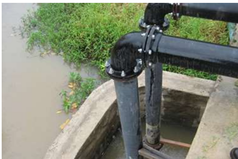
Figura 5 - Tubulações de captação na nova Barragem
