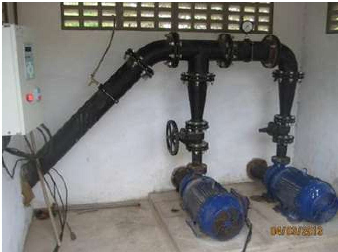
Figura 7 - Conjuntos Motobomba da Estação Elevatória de Água Bruta
