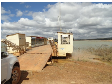
Plataforma de atracação, com sistema de engrenagens.
